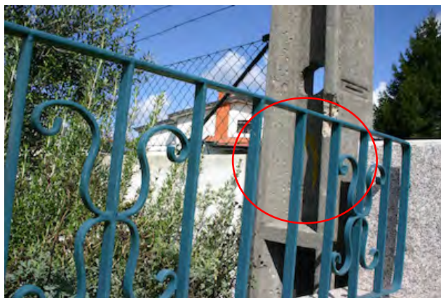
Imagem 17. Cruzamento em Águas Santas (Maia). A seta amarela mostra uma mudança de direção, mas está situada no interior de uma propriedade privada não sendo devidamente visível. Fonte: elaboração própria.
