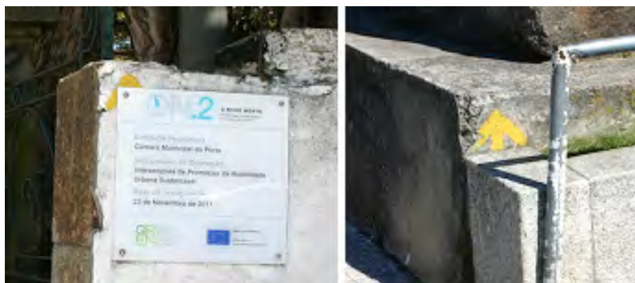
Ilustração 22: Sinais parcialmente cobertos por objetos que dificultam a sua visibilidade, no Troço do Caminho que vai do Porto à Freguesia de Gião em Vila do Conde. Fonte: elaboração própria
