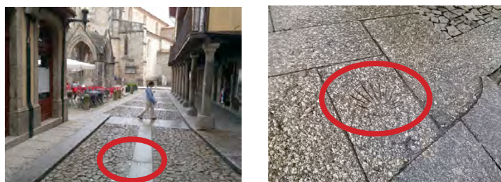
Figura 10 Exemplos de sinais com pouca visibilidade devido aos materiais escolhidos para a sua composição
