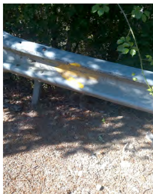
Figura 38 Exemplos de marcas pintadas incorretamente localizadas
