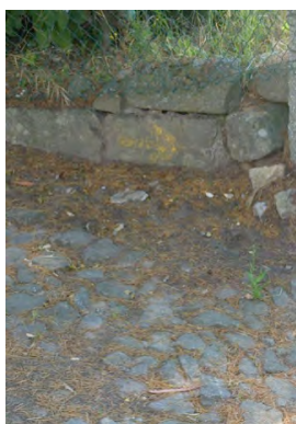
Figura 40 Exemplos de marcas pintadas gastas (sem manu- tenção periódica)
