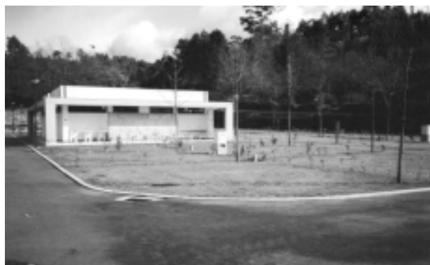
Figura 11 Interior do Parque de Campismo da Barragem da Queimadela.
