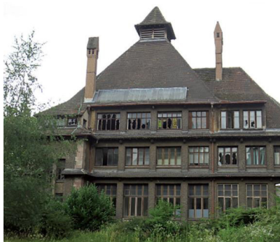
Uno de los edificios del complejo hospitalario antiguo. Fuente: SERS.
