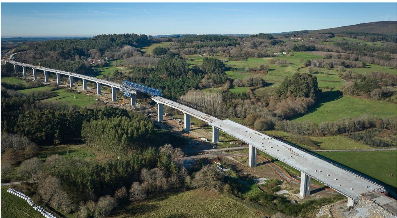
Viaduto sobre o rio Pambre do troço Melide - Palas de Rei, com 977 metros de comprimento (ACCIONA).
