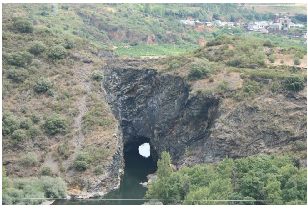
Vista augas arriba e augas abaixo do túnel.
