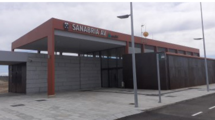
Estación del AVE en Otero de Sanabria con la que conectará la nueva carretera Bragança-Sanabria, salida de alta velocidad para los habitantes de Tras-ós-Montes
