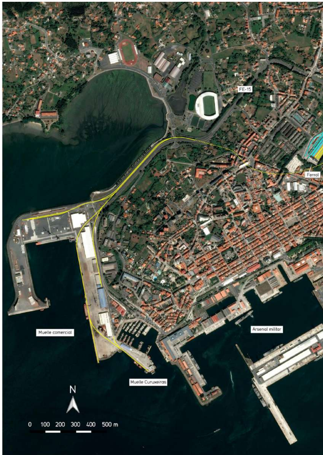
Figura 31. Red ferroviaria existente en el puerto de Ferrol.
