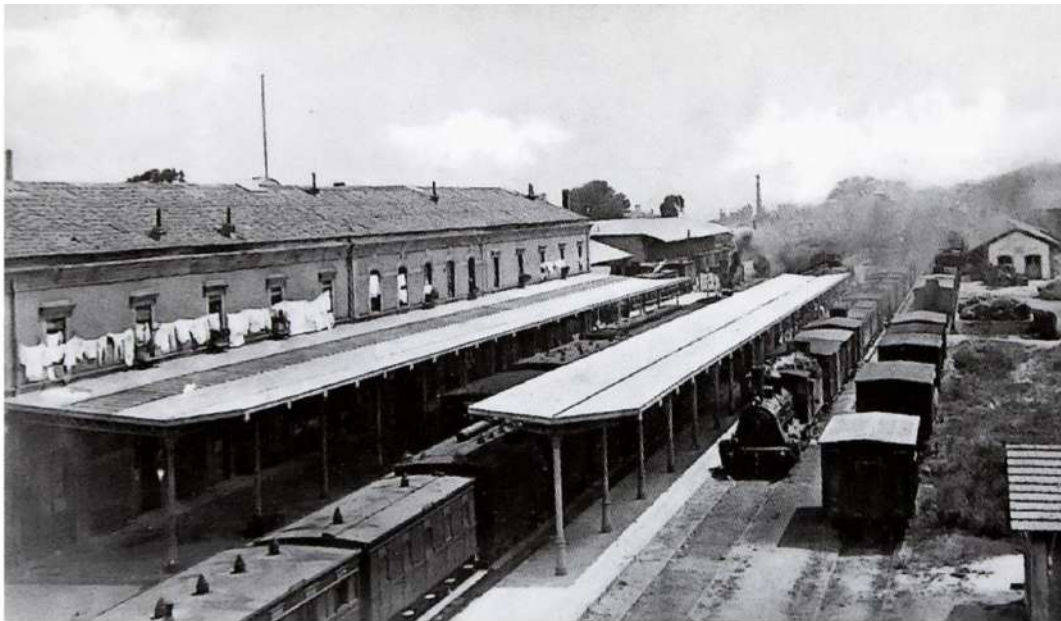
Figura 3. Estación del Norte en A Coruña.
