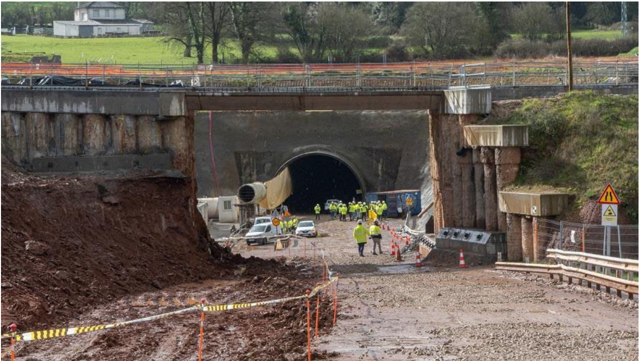
Túnel de Oural, de 1,9 kilómetros es la obra más relevante del corredor. (Foto Adif).
