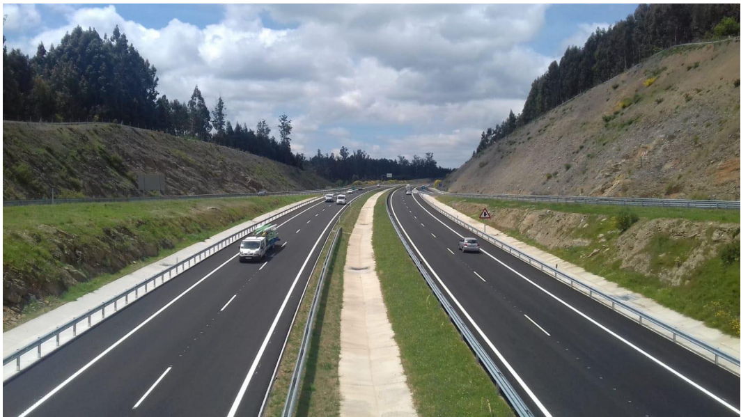
Autovía A-54 Lugo-Santiago, tramo Lavacolla-Arzúa, en servicio desde 2019. (Ministerio de Transportes).
