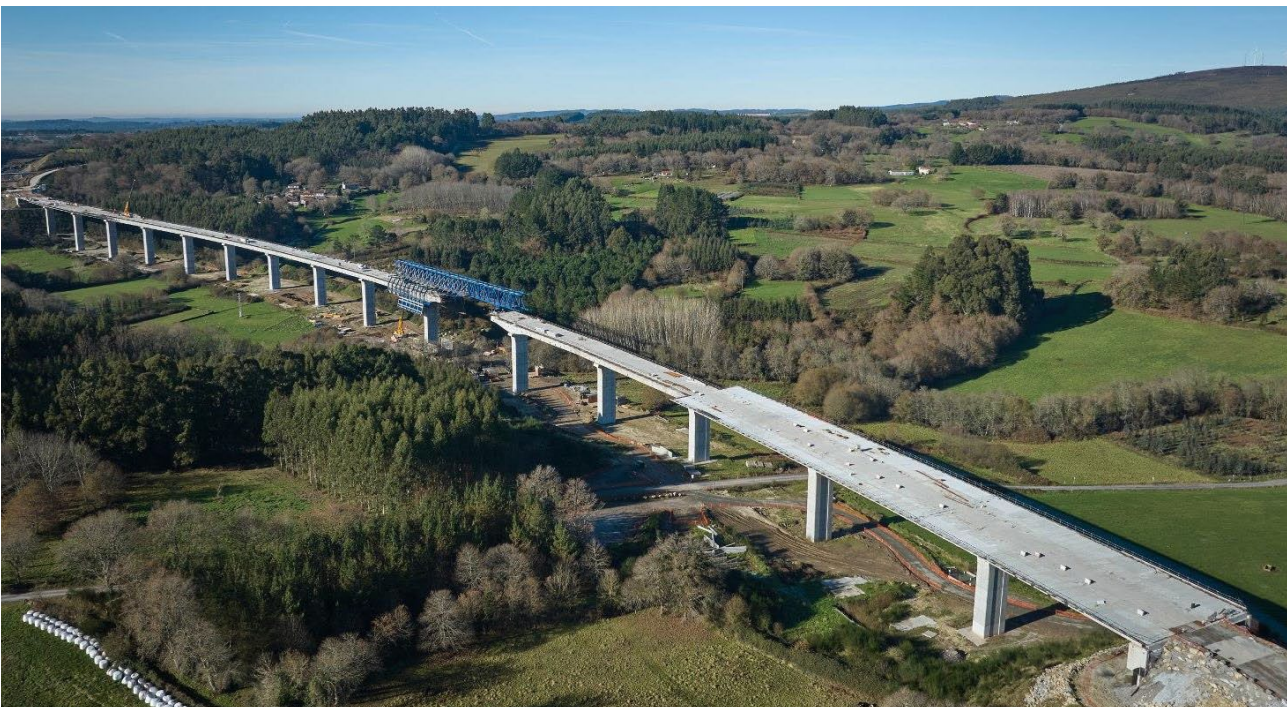
Viaducto sobre el río Pambre, del tramo Melide-Palas de Rei, de 977 metros de longitud (ACCIONA).
