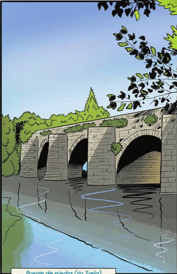
Puente de piedra (río Tuela)
