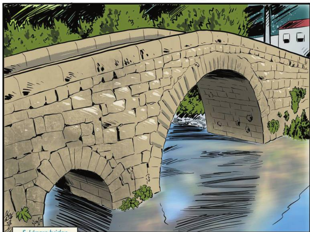
S. Lázaro bridge
